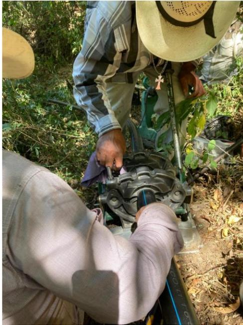
En la comunidad de tepantla Se construyeron 11 cajas reguladoras de agua potable, con la instalación de válvulas.
